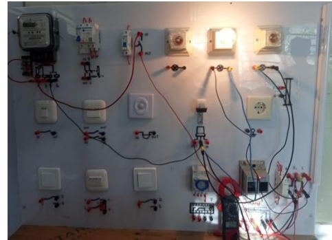
Gambar 24.. Pengukuran arus pemasangan MCB, kontaktor dan WLC omron.
